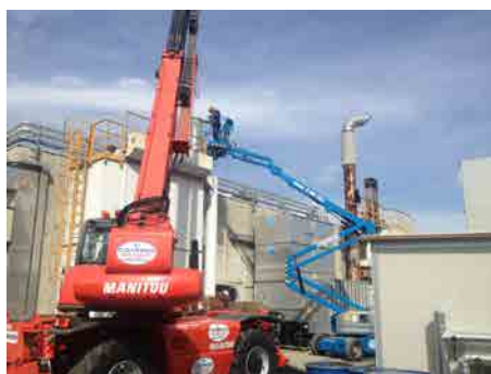
Smontaggio impianto. Plant disassembly
